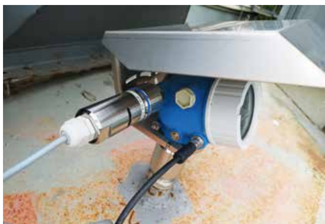
Désormais facile d'accès grâce à l'installation d'un FieldPort SWA50
