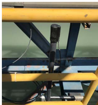
Ultraschall Trennschichtsensor Turbimax CUS71D, der in einen Spiegel aus geklärtem Wasser getaucht wird; die Montage erfolgt auf der Brücke des Eindickers Nr. 2U
