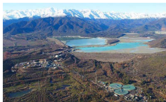
Moderne Instrumente in Eindicker verbessern die Klarwassergewinnung und maximieren den Feststoffgehalt im Ablauf
