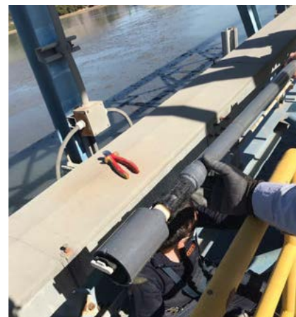
Ultraschall Trennschichtsensor Turbimax CUS71D, der in einen Spiegel aus geklärtem Wasser getaucht wird; die Montage erfolgt auf der Brücke des Eindickers Nr. 2U
